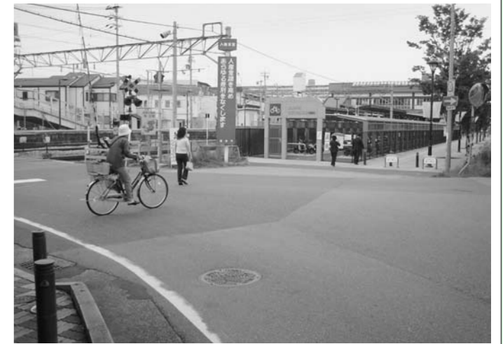
▲早期の整備が望まれる駅西踏み切り南側
