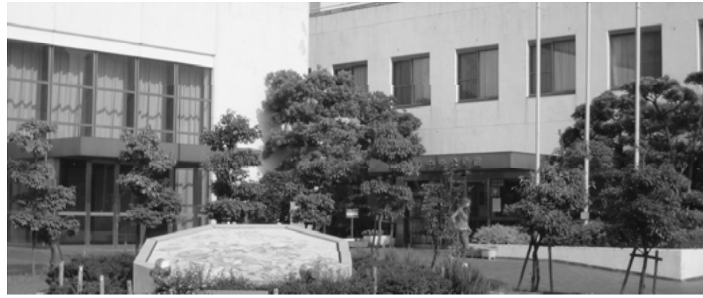
▲いよいよ夏本番 空調設備の改修が進められる中央公民館
